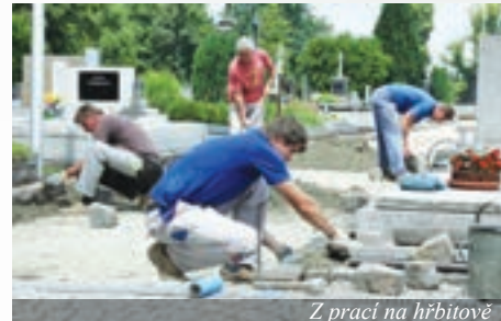
Z prací na hřbitově
