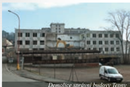
Demolice správní budovy Tepny
