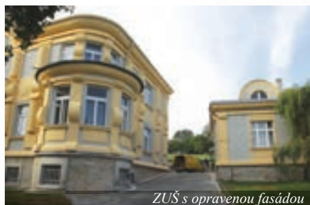
ZUS s opravenou fasádou
