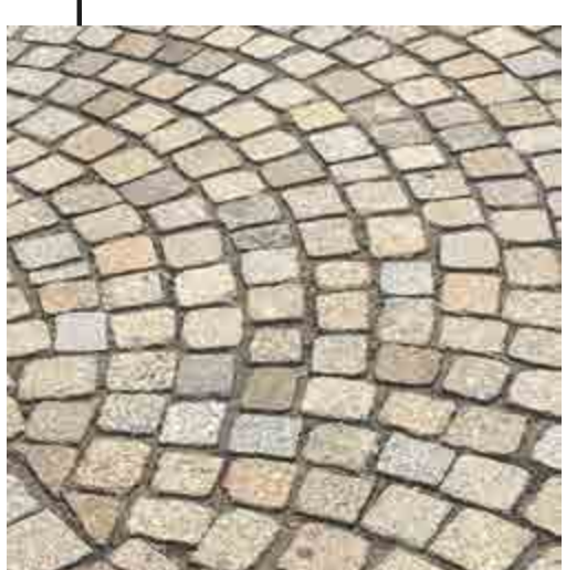
vozovka u nádraží kostka kladená do vějíře ze žlutošedé žuly
