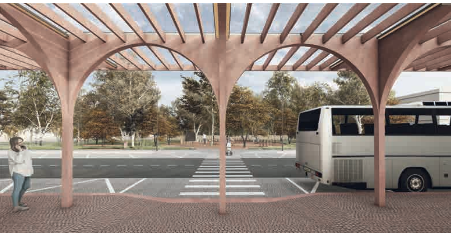
ocelová konstrukce zastřešení zastávky, zastřešení bezpečnostním sklen zastřešení ocelové podpory - nádrž ze 2012
