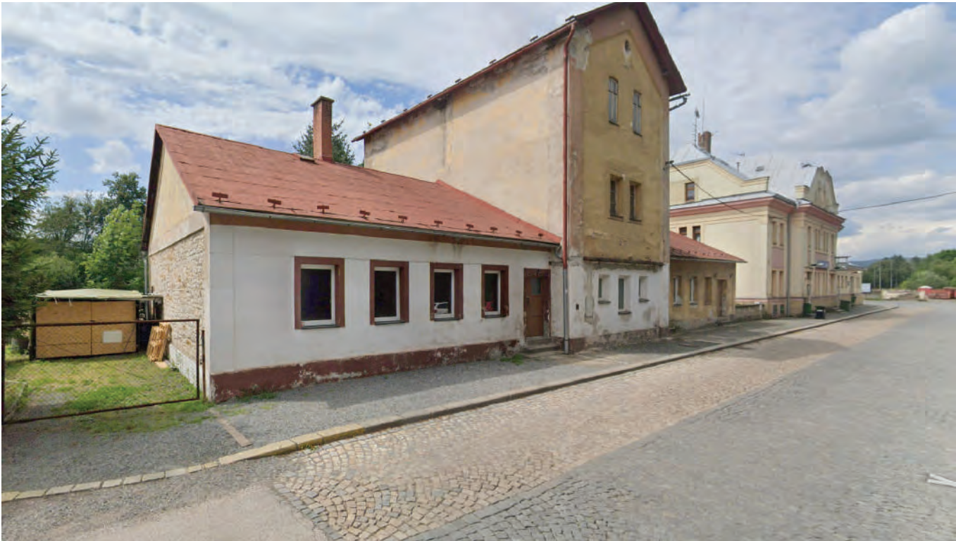
fotografie stávajícího stavu /pohled z ulice/ - stará nádražní budova
