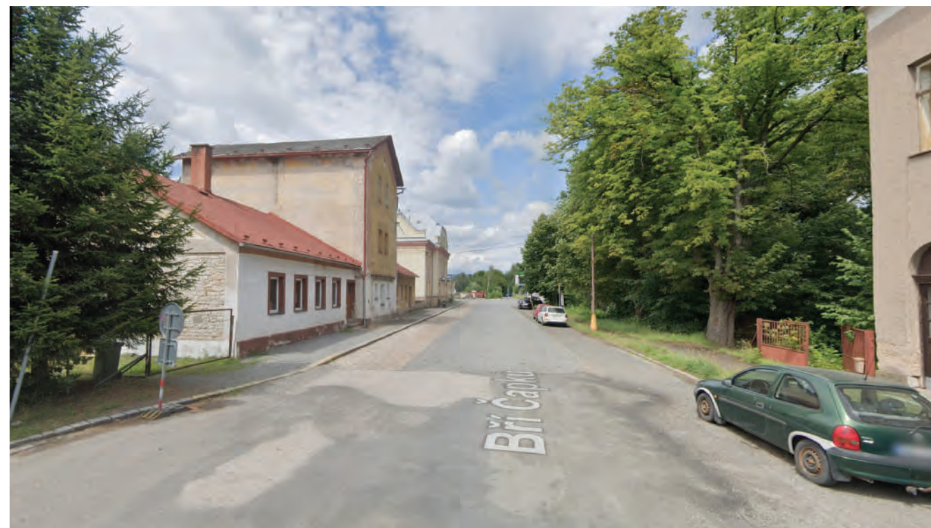
fotografie stávajícího stavu - ulice a stará nádražní budova
