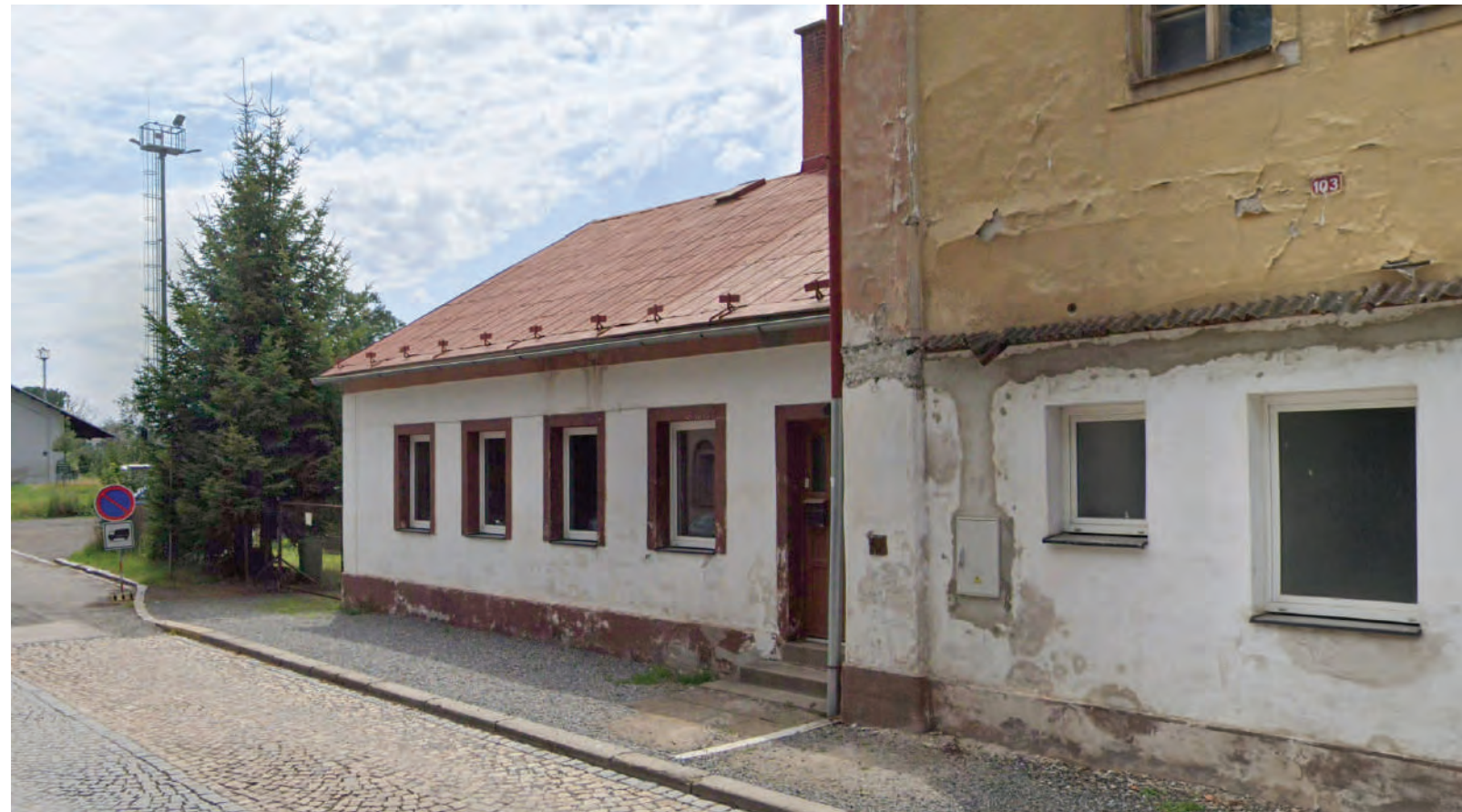
fotografie stávajícího stavu - stará nádražní budova
