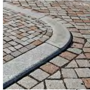
obrubníky vozovek žlutošedá žula
