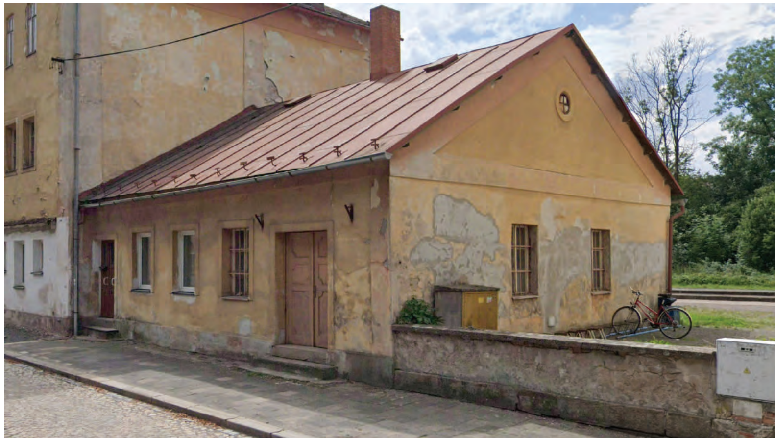
fotografie stávajícího stavu - stará nádražní budova
