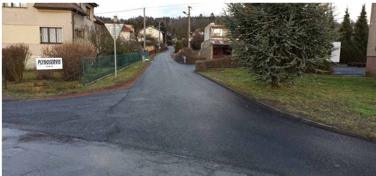
Fotografie ulice Podlesná 2 těsně po dokončení její rekonstrukce
