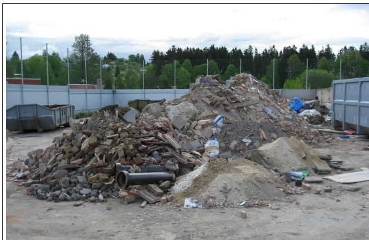
Obrázek 16 – Stavební a demoliční odpad – ilustrační foto
