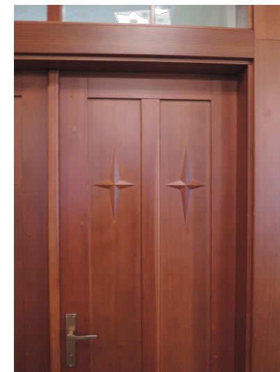
FOTO STÁVAJÍCÍCH DVEŘÍ, KTERÉ ZŮSTANOU ZACHOVÁNY - DETAIL ŘEZBY S TÍMTO DETAILEM BUDOU VYROBENY I SOUSEDNÍ NOVÉ DVEŘE VLEVO I VPRAVO
