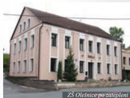
ZŠ Olešnice po zateplení
